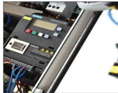
SIEMENS V20 INVERTER
